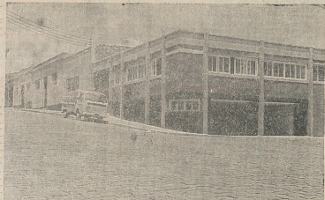
Uma parte do novo prédio, que ocupa quase meio quarteirão na Vila Montenegro
