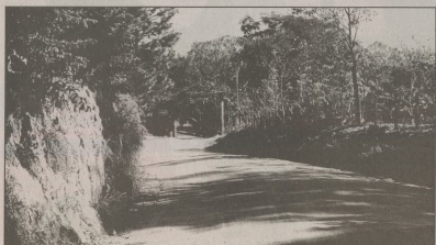
A avenida antes
