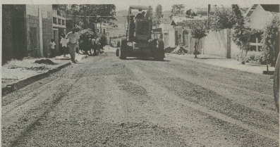
Rua recebendo reparos em toda sua extensão
