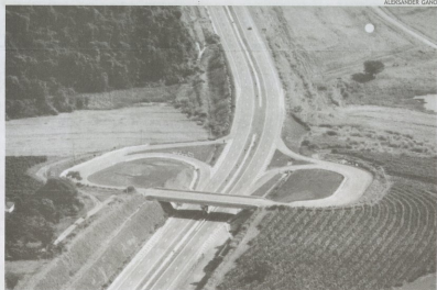
Um dos trevos retorno da Rodovia Mogi Guaçu/Pinhal
