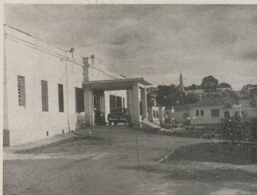
Vista parcial do Hospital «Francisco Rosas»
