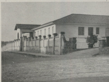
Vista parcial da Maternidade «Maria de Azevedo Florence»
