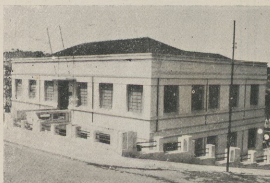
Vista parcial do Centro de Saúde
